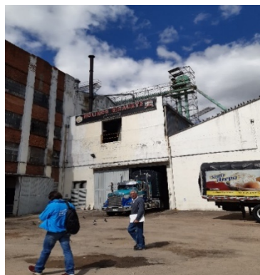
FOTO 1. FACHADA DEL PREDIO
